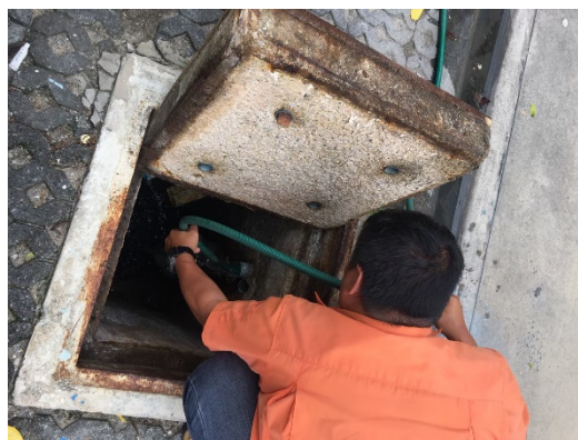
รูปที่ 36 พนักงานทำความสะอาดและตรวจสอบรางระบายน้ำเมื่อพบว่า มีตะกอนสะสม
