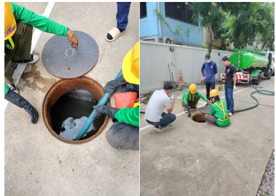
รูปที่ 40 การสูบน้ำจากกระบบบำบัดไปกำจัด
